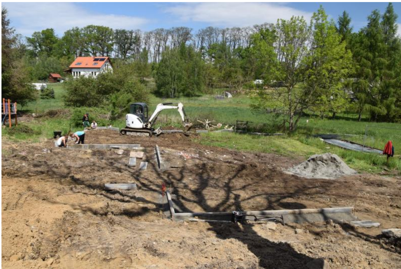
Zdjęcia świetlicy wiejskiej w Pęgowie
