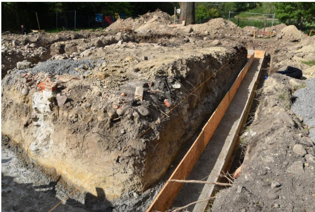
Fundamenty świetlicy w Bagnie
