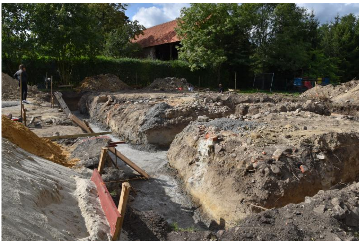
Fundamenty świetlicy w Bagnie
